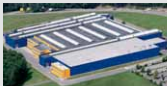
Hörmann KG Eckelhausen, Allemagne
