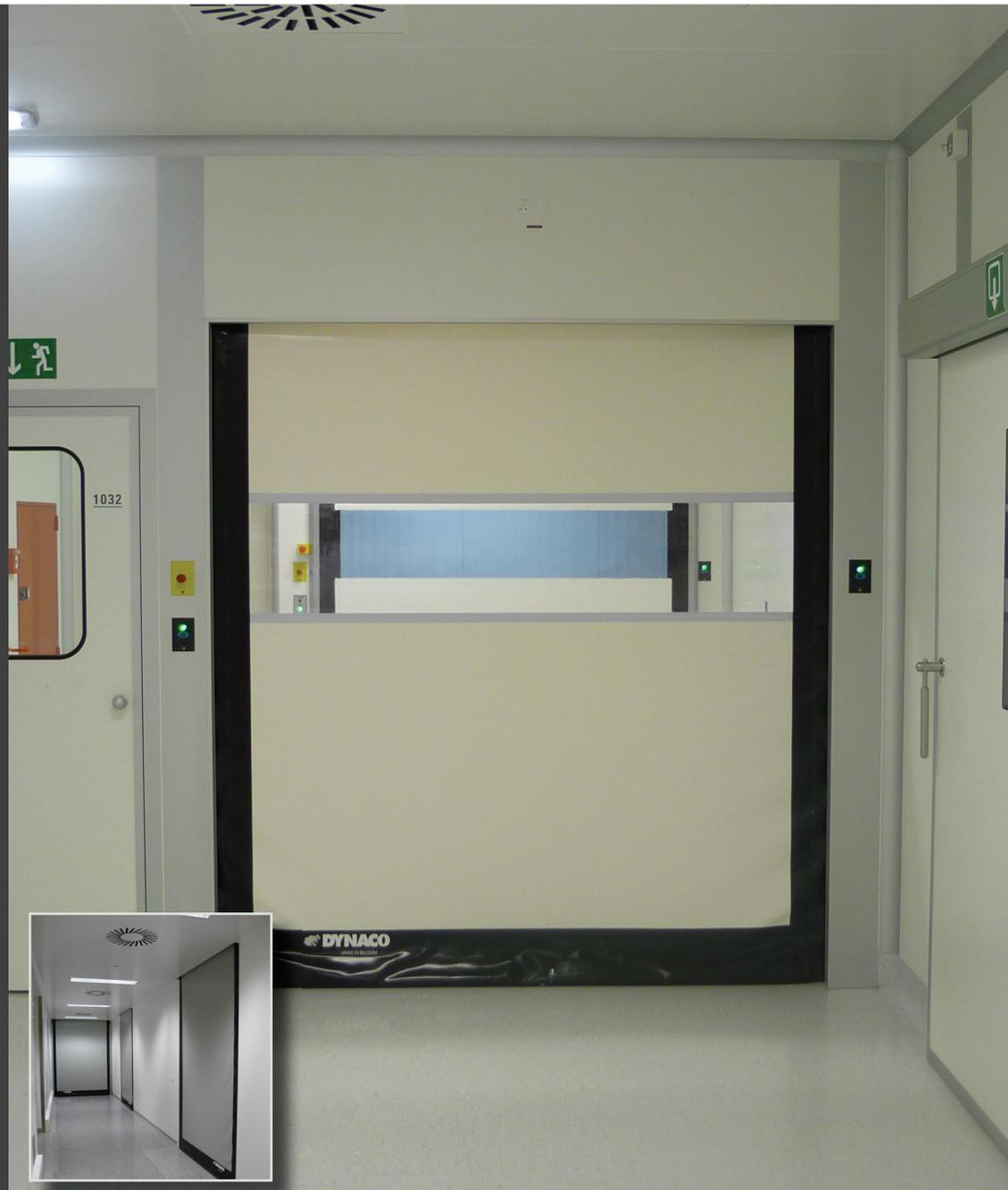
La D-311 Cleanroom LF de DYNACO est conçue pour des applications intérieures qui demandent une limitation du débit de fuite. Elle est idéale pour les interlock. Sa parfaite étanchéité assure le contrôle de l'environnement et la protection contre les courants d'air, la poussière et les impuretés.
